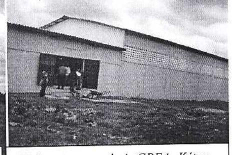
Bâtiment provenderie CPEA- Kétou
